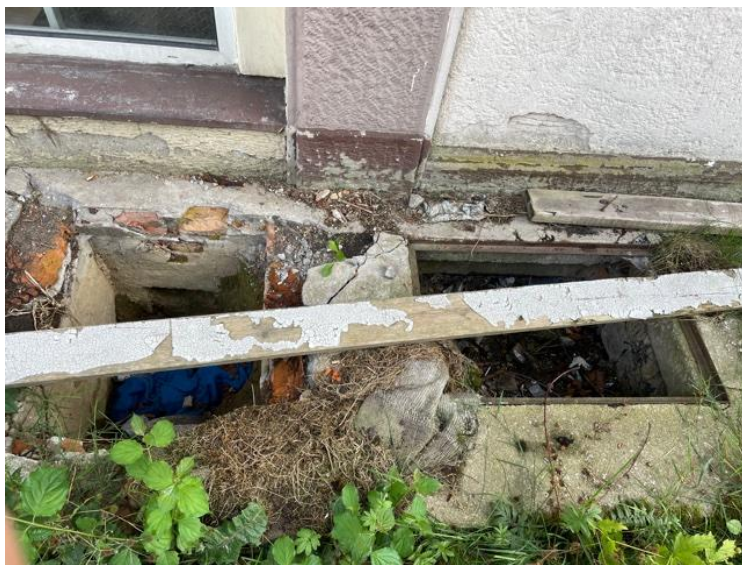
Fotografie stávající šachtice přípojky plynovodu na východní straně odstraňované budovy ZŠ
