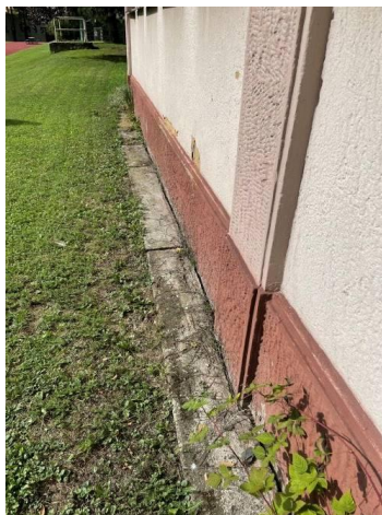
Fotografie betonového okapového chodníku okolo objektu ZŠ o celkové délce cca 125 m.
