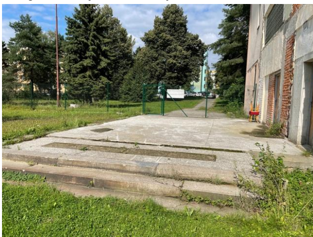
Fotografie ŽB desky po odstraněné části koridoru
