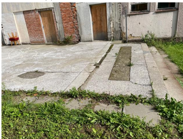
Fotografie ŽB desky po odstraněné části koridoru
